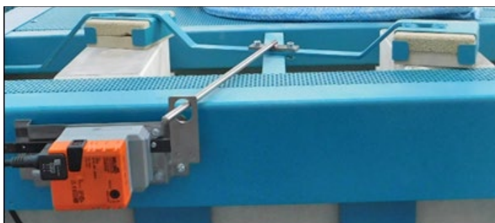
Afbeelding 25: Automatische luchtafvoerklap
